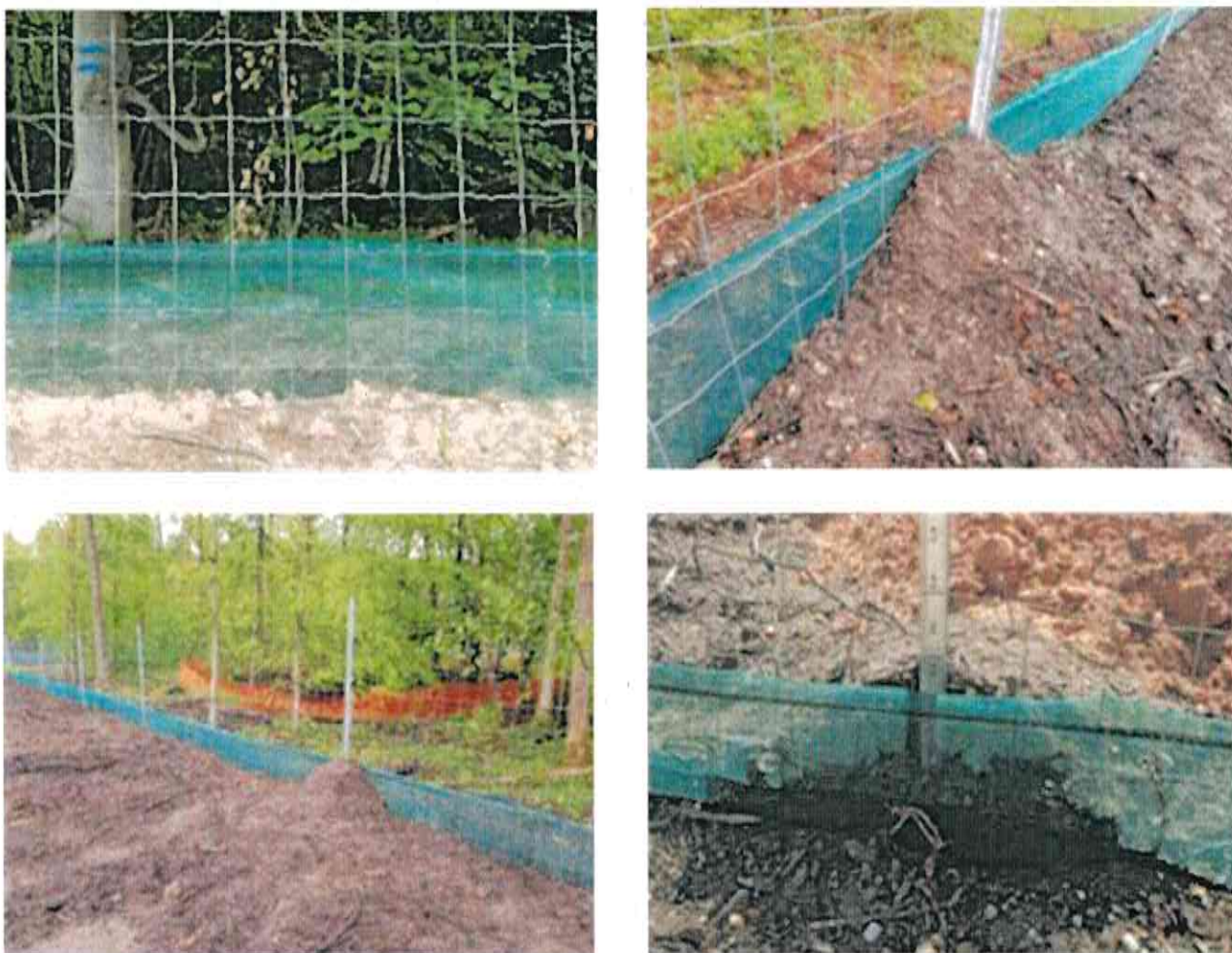
Figure 11 : Exemple de dispositif anti-intrusion semi perméable (photos : Biotope).
